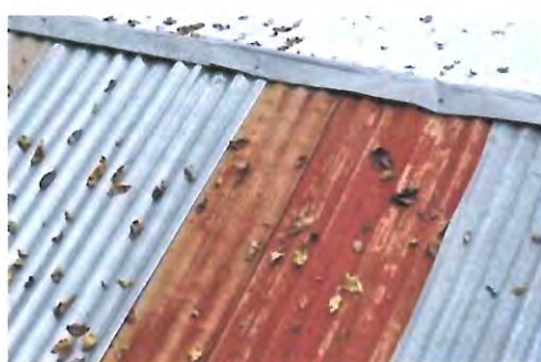
CUBIERTA DE LAMINA, SUSTITUCION DE CAPOTE
