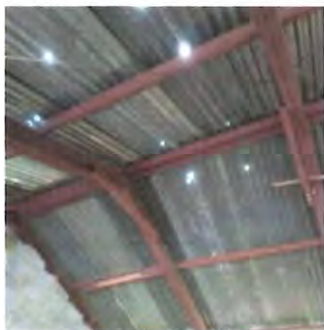
CUBIERTA DE LAMINA, SUSTITUCION CUBIERTA DE LAMINA MAL ESTADO
