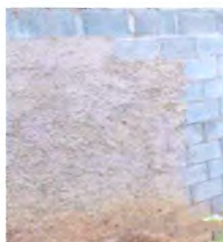
REPELLO EN MUROS, APLICACIÓN EN REPELLO EN MUROS POR AFECTACION POR HUMEDAD
