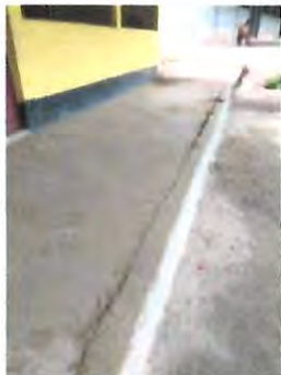
LOSA DE PATIO, REPARACION LOSA DE PATIO
